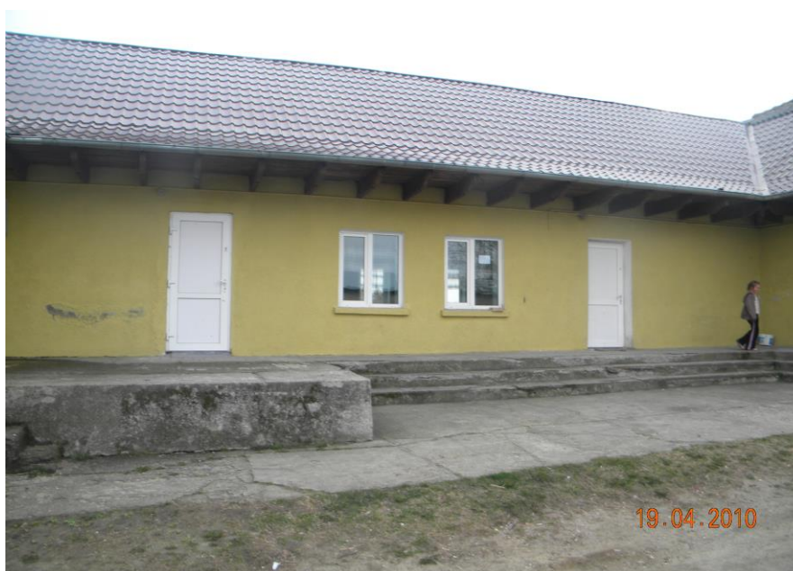
Rys.9 Budynek świetlicy wiejskiej w Klutajnach-widok z zewnątrz.
