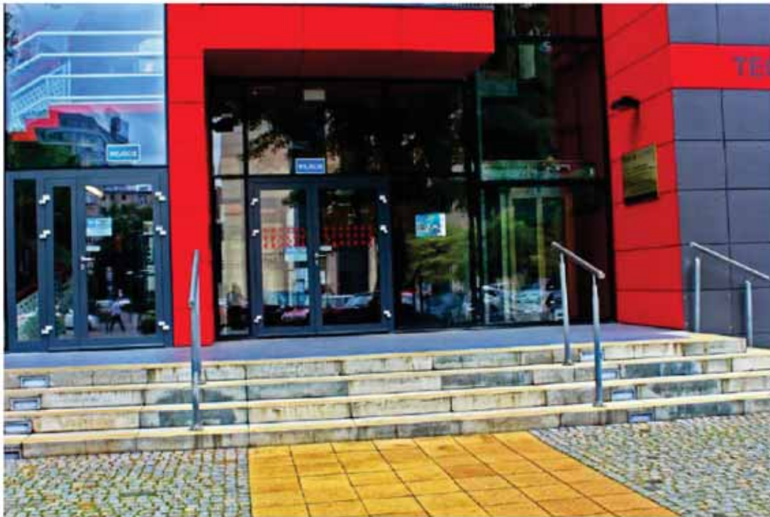
Rysunek 40. Przykład naprowadzenia systemu FON na wejście główne do budynku szkoły [fot.: N. Ratajczak-Szponik].
