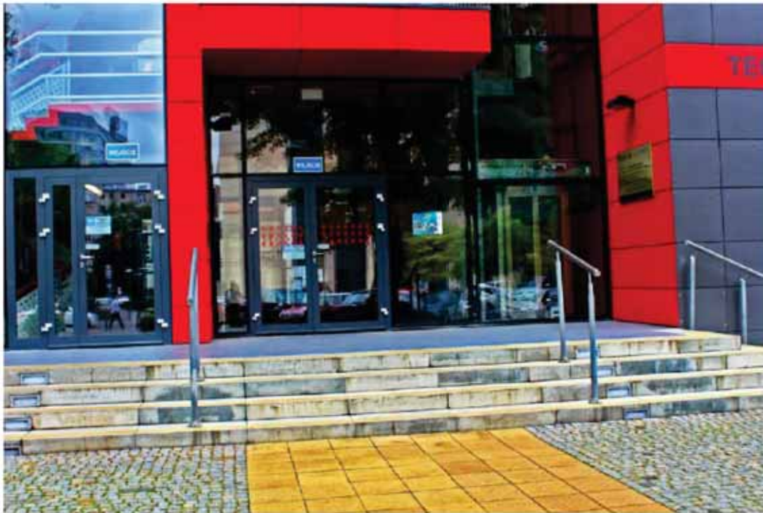
Rysunek 40. Przykład naprowadzenia systemu FON na wejście główne do budynku szkoły [fot.: N. Ratajczak-Szponik].
